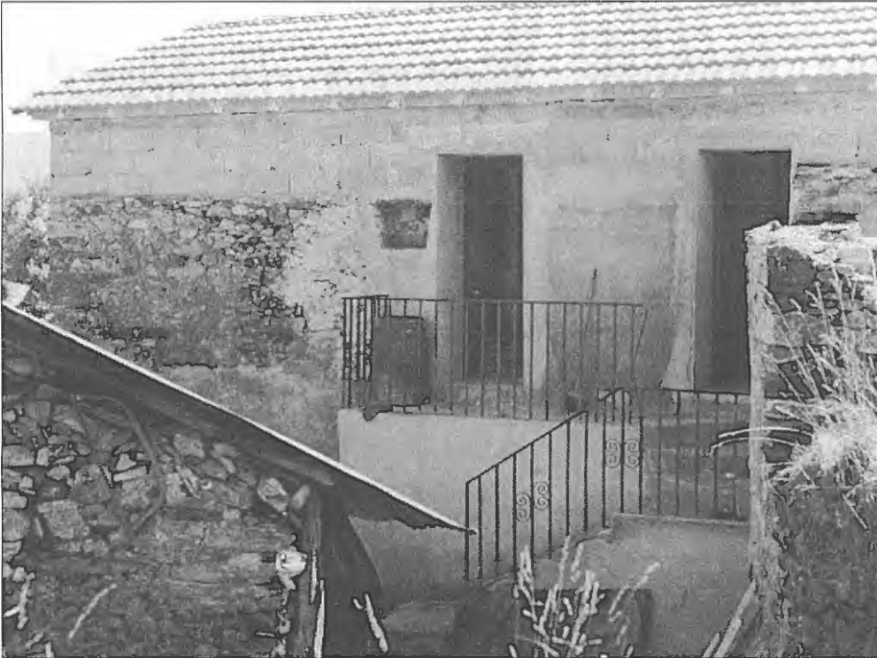
A habitação do casal está a ficar pronta. Agora, anda a casinha da mãe-avó em obras.
